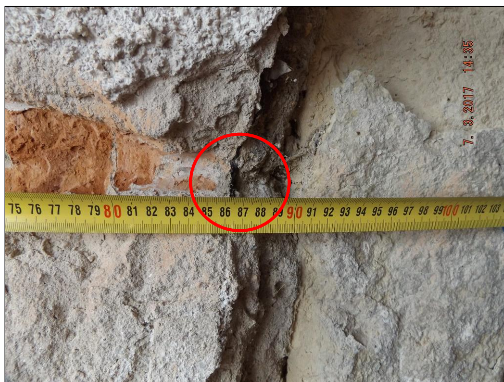
Obr. č. 14 - detailní pohled na sondu SO2 pro ověření existence hydroizolace, která je vyznačena červeným polygonem.
