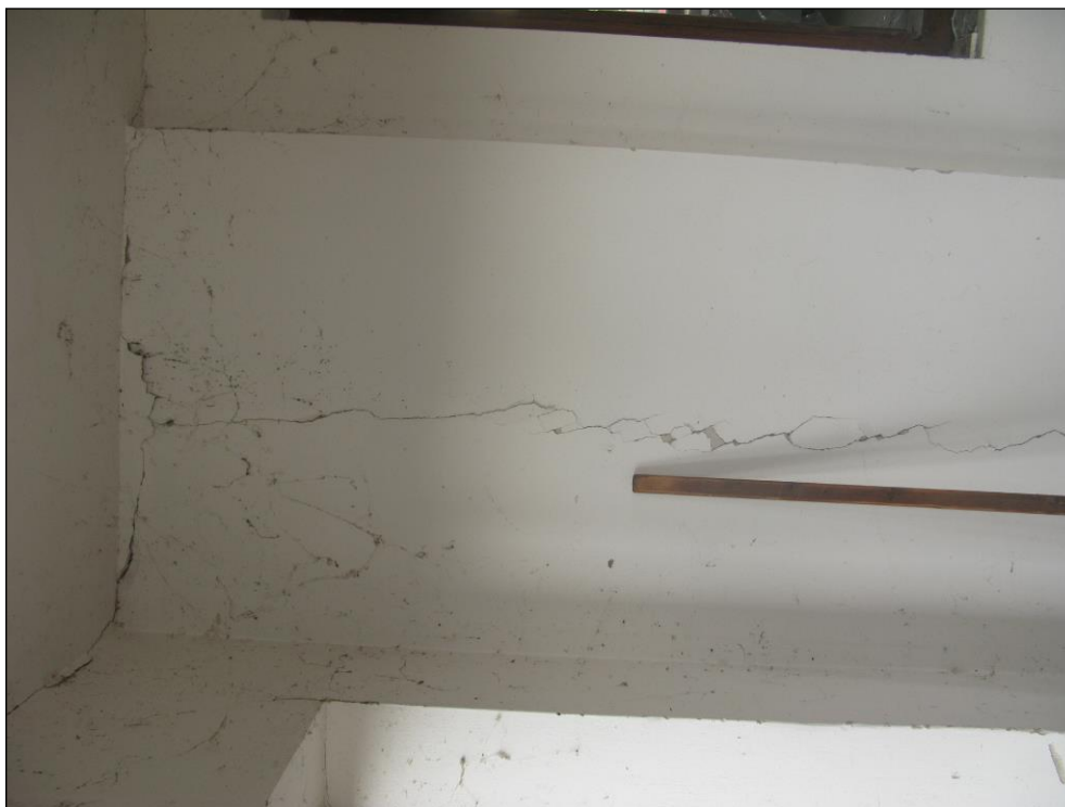
Obr. č. 21 - pohled na svislou, průběžnou trhlinu na vnitřním líci zdi místnosti zádveří při vchodu do objektu.
