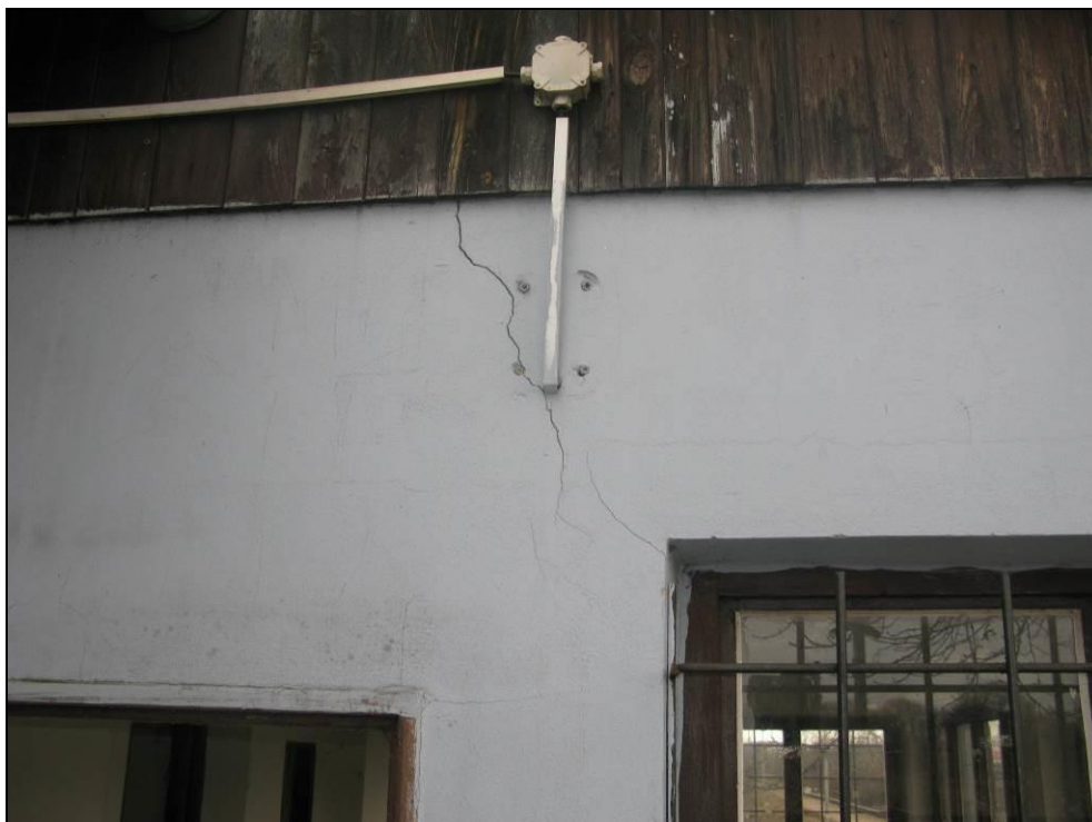
Obr. č. 19 - pohled na vrubovou u okenního otvoru u vchodu do místnosti zádveří.
