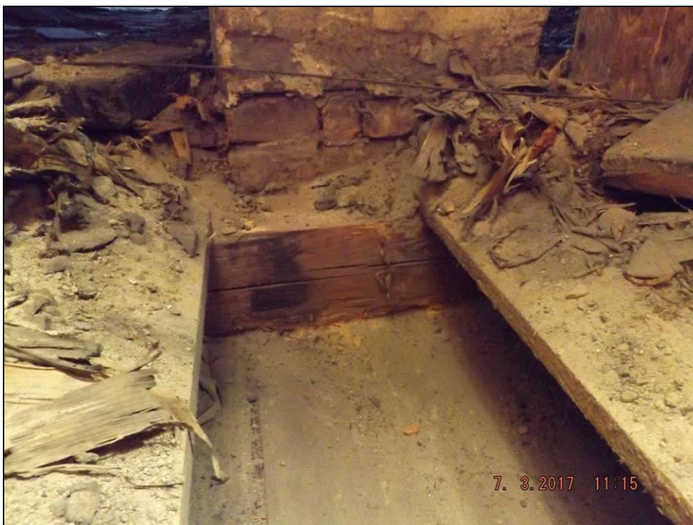
Obr. č. 12 - pohled na částečnou „rozebírku“ (sonda SO3) stropní konstrukce nad služební místností pro ověření jeho skladby.
