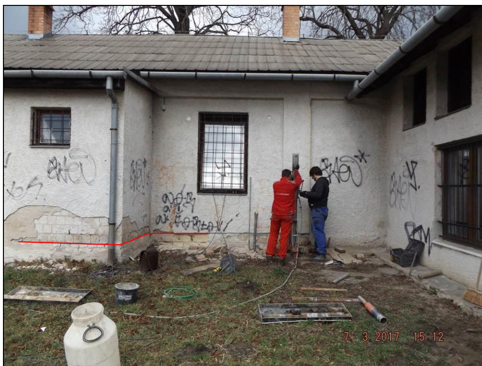
Obr. č. 16 - pohled na opady omítky na vnějším líci jižně orientované zdi objektu; v místech opadů, v linii červeně vyznačených přímk, byla makroskopicky ověřena existence hydroizolace.
