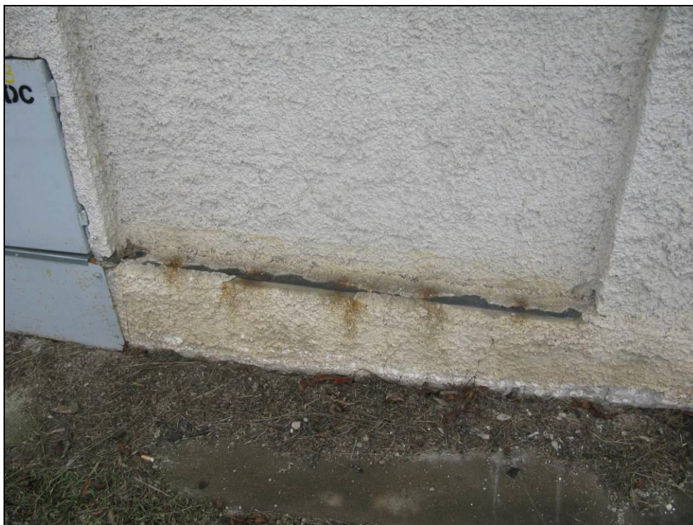
Obr. č. 15 - detailní pohled na obnaženou hydroizolaci v místech opadů omítky na vnějším líci východně orientované zdi (viz obr. č. 2).
