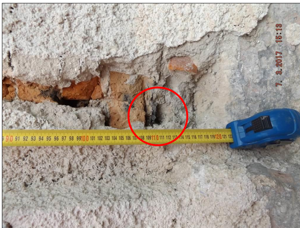
Obr. č. 13 - detailní pohled na sondu SO1 pro ověření existence hydroizolace, která je vyznačena červeným polygonem.
