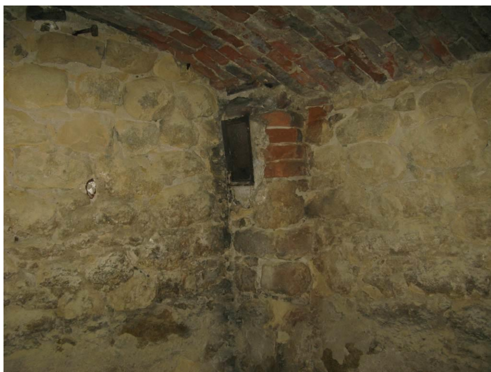
Obr. č. 18 - sklepní místnost pod kuchyní, vymetací otvor komína.
